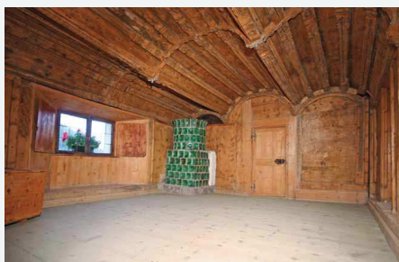
Südflügel, gotische Bohlenstube mit spätgotischem Kachelofen. Ala meridionale, stube gotica in legno con stufa in maiolica di epoca tardogotica. South wing, gothic plank room with late-gothic tile furnace.
