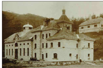
Elektrizitätswerk Rundl im Jahre 1903. Ein symbolträchtiger Prachtbau. Die schlossartige Architektur des Kraftwerks weist darauf hin, welche Bedeutung man der neuen Energie beimaß.
