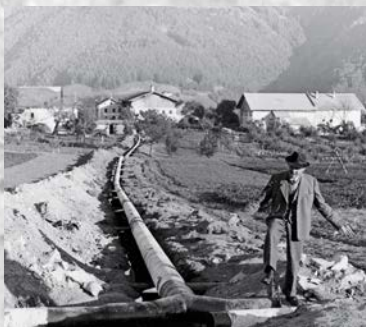
Verlegung der Rohre auf den Wiesen in Natz. Posa dei tubi sui prati di Naz. Laying down of the pipeline in the meadows of Natz.
