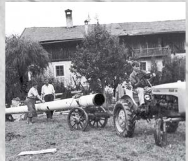
Verteilung der Rohre auf den Wiesen und Feldern. Distribuzione dei tubi sui prati e campi. Distribution of the pipes to the meadows and fields.
