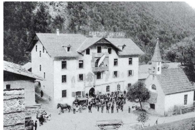
Der Gasthof Untererau verschwand mit den weiteren Häusern und der Kapelle des Ortes in den Fluten des Stausees.
