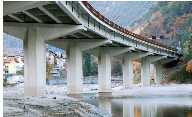
Eine große technische Herausforderung war der Bau der bis zu sieben Meter tiefen Fundamente für die Brücke über den Stausee.
