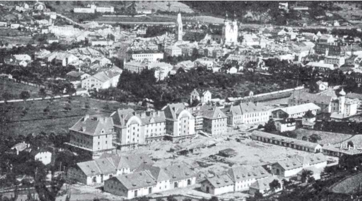
Artilleriekaserne kurz vor der Fertigstellung.
