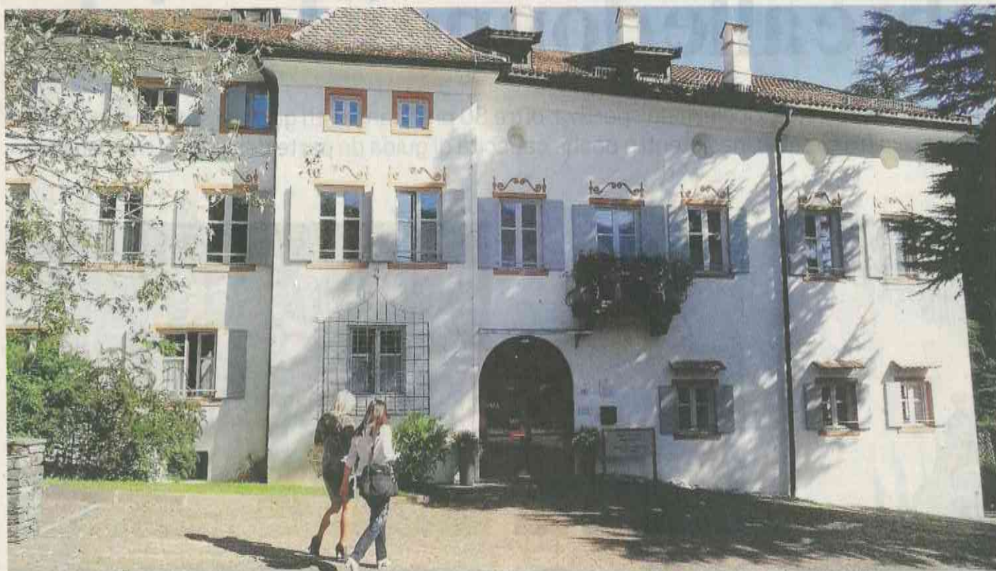
• In programma lavori di risanamento e ristrutturazione nel complesso per persone con disabilità Seeburg a Bressanone (foto De Villa)
