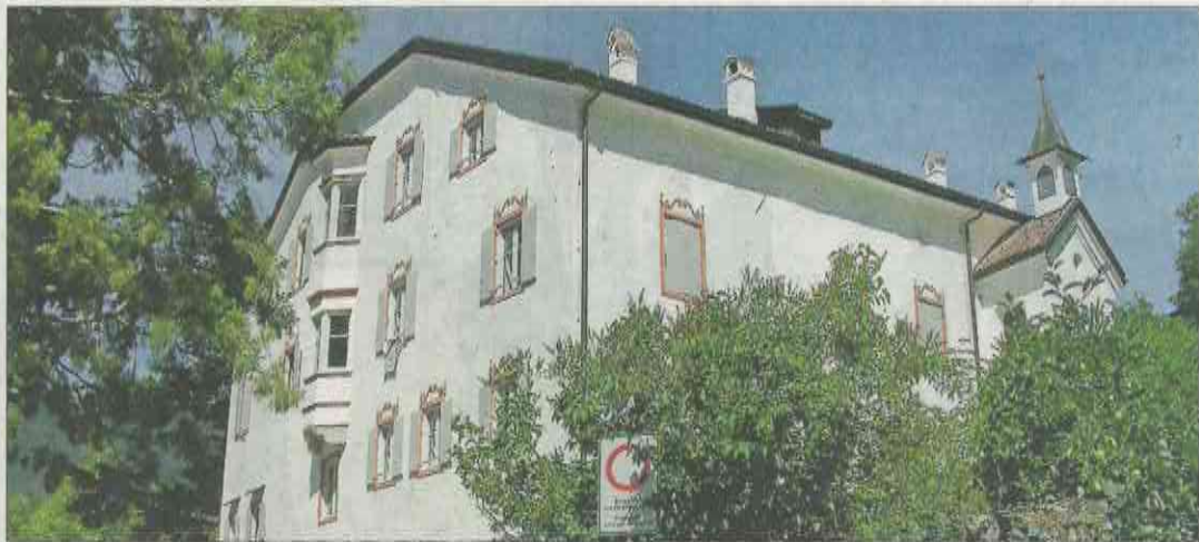
Im nächsten Jahr wird die Dachkonstruktion der Seeburg erneuert, die Einrichtung bleibt dabei in Betrieb. jt
