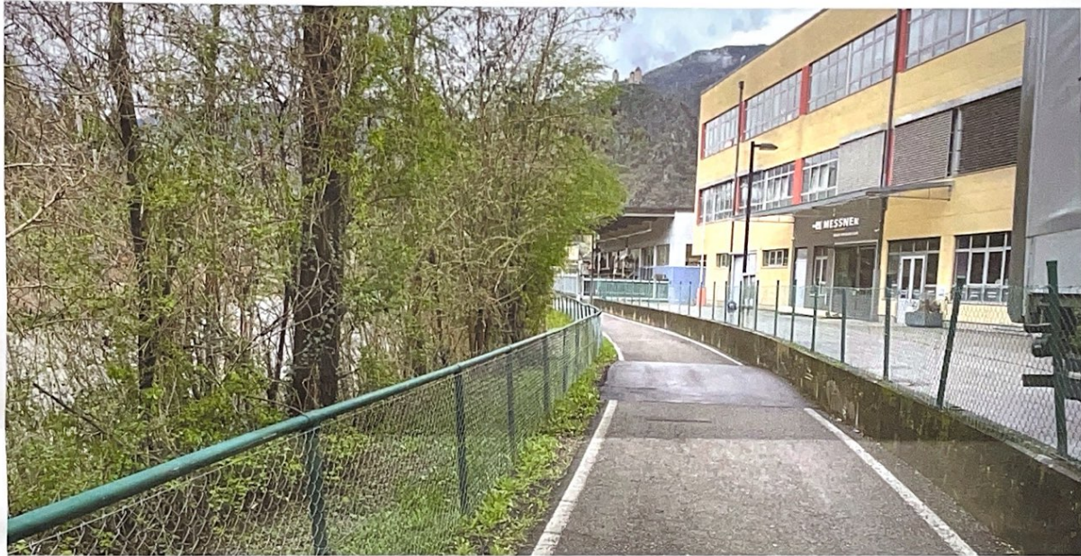
Radweg in Klausen: Auch hier wurde gebaut
