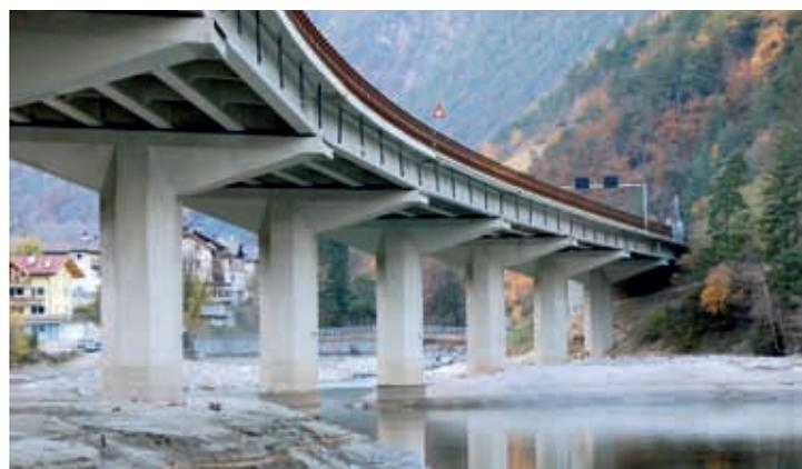
Una notevole sfida dal punto di vista tecnico fu la costruzione delle fondamenta (profonde fino a sette metri) dei piloni per il ponte sul lago artificiale.
